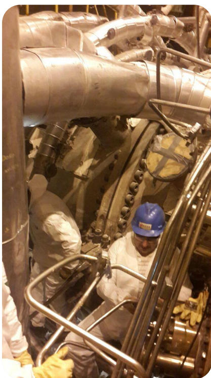
Turbina de Gas 8
