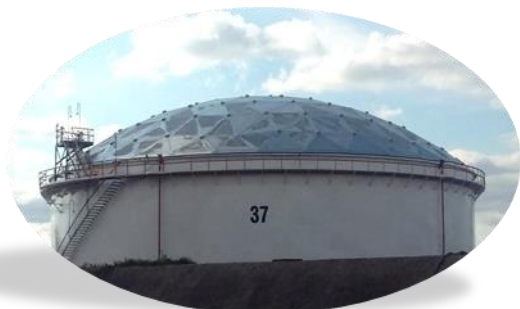
TK 37. Axion Energy. Reparación General
