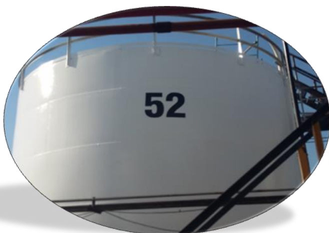
TK 52. Axion Energy. Reparación General
