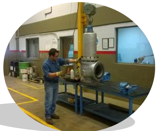
Taller prefabricado: Banco de Válvulas (Bahía Blanca)
